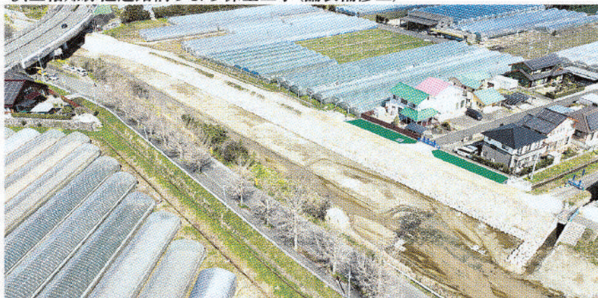
横田川広域河川改修工事(旧堤防撤去)
