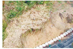
災害現場の調査
