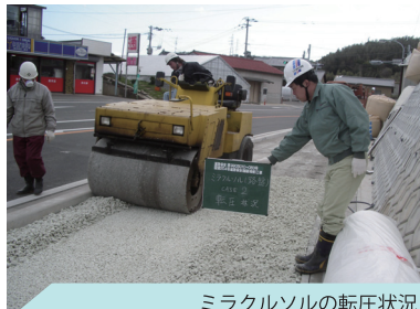
ミラクルソルの転圧状況
